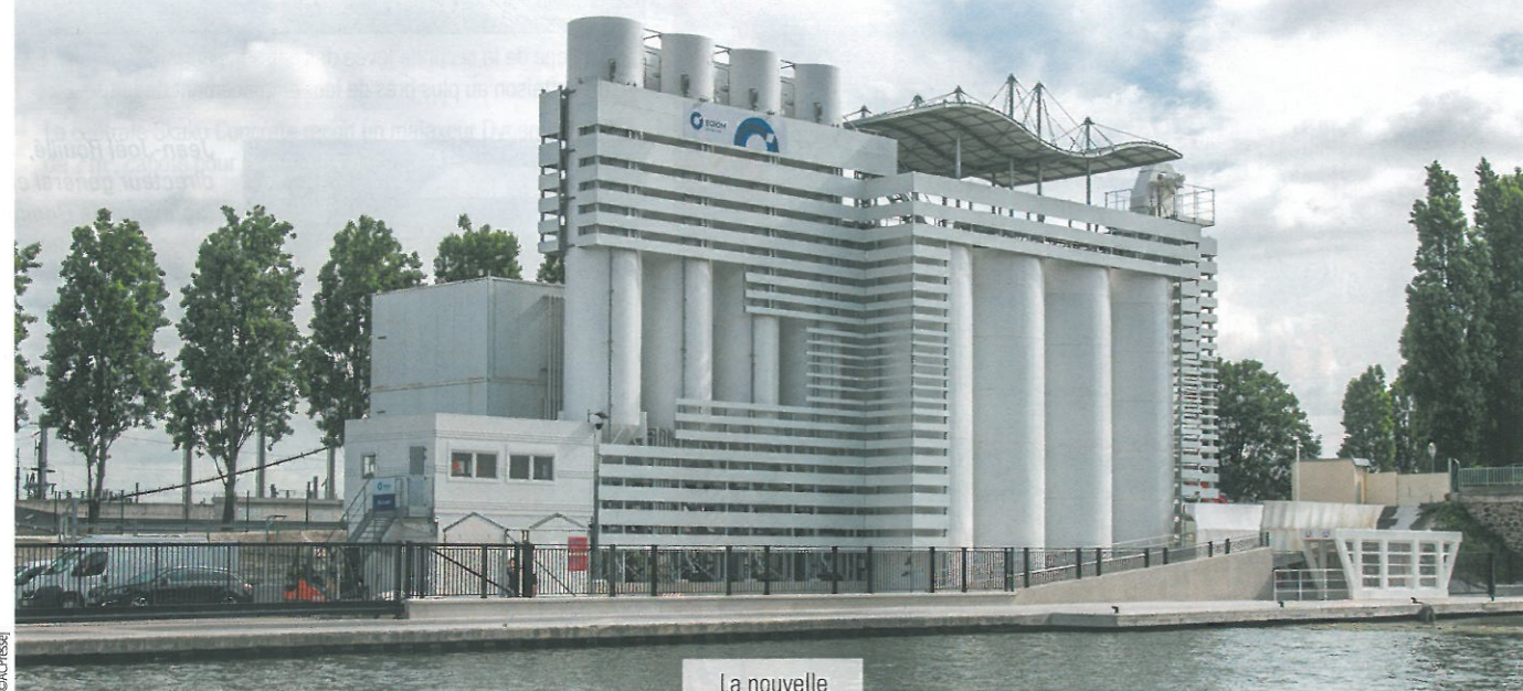
La nouvelle centrale à béton Eqiom de Pantin s'inscrit exactement dans l'encombrement de l'ancienne unité, reprenant au passage une bonne partie de son génie civil.
